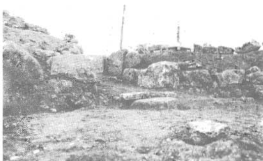
Fig. 11 - Casa A, particolare del corridoio d'accesso; il masso sul fondo del corridoio non è strutturale, ma di contenimento per i materiali di risulta di scavo.
